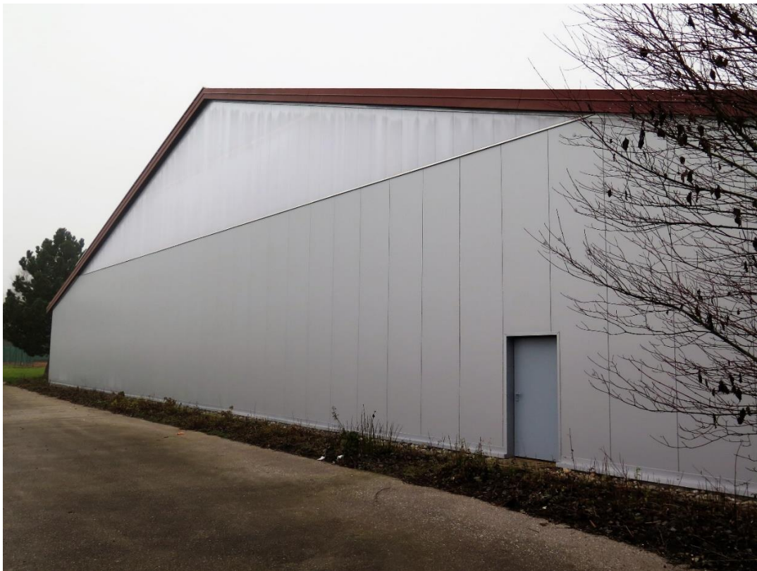
Hallenostseite nach der Renovierung im Oktober 2015
